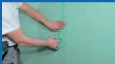
**1.** Appliquez d'abord la bande de jointoiment Hydro Joint Mix sur les joints. Procédez aussi de la sorte si vous souhaitez simplement appliquer du carrelage.
