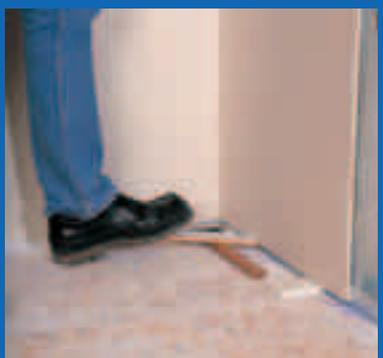
**4** Découpez un profilé MSV50 à longueur (1 à 1,5 cm plus court que la distance entre le sol et le plafond) et placez-le contre le mur. Positionnez le profilé à la verticale parfaitement d'aplomb (avec un niveau à bulle) et fixez-le au mur tous les 80 cm. Placez ensuite le profilé MSH50 au plafond et procédez de même sur le mur opposé.
